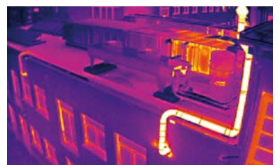
Surveillance de température dans la thermographie du bâtiment
